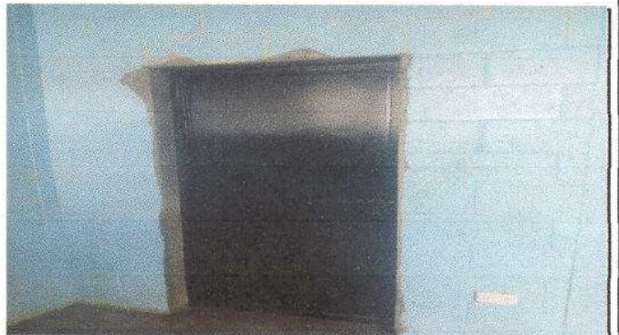
Foto 10: Apertura, fabricación e instalación de puerta
