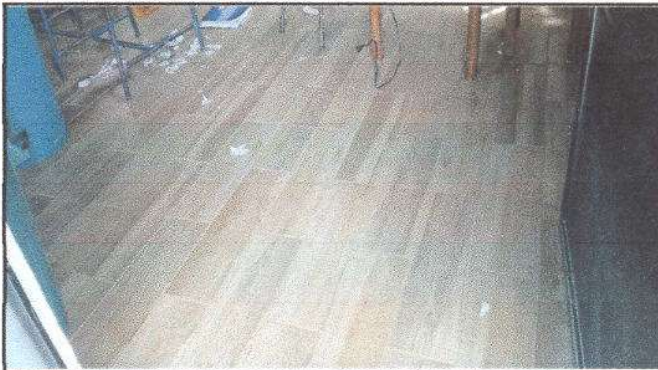
Foto 1: Sustitucion de piso cerámico color beige madera, aula de párvulos.
