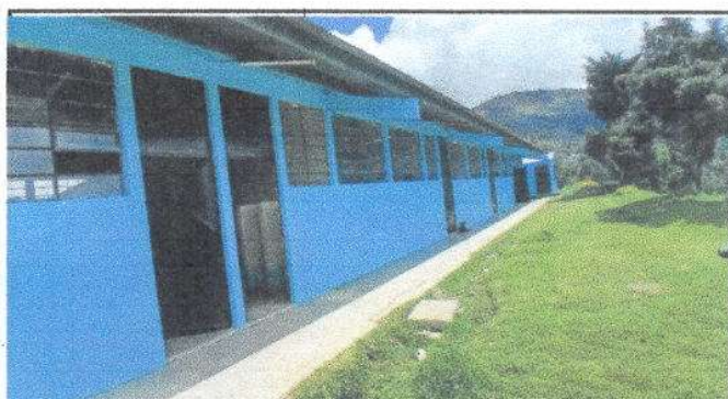
Foto 9: Aplicación de pintura color celeste en muros exteriores módulo II
