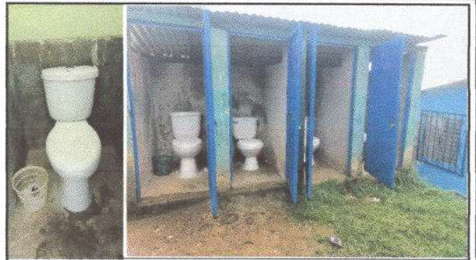
Foto 2: Sustitucion de accesorios inodoro (contrallave, tubo de abasto y tanque).
