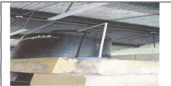
Foto 5: Sustitucion de accesorios de deposito de agua
