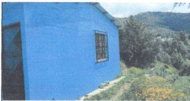
Foto 5: Fabricación e instalación de ventana-balcon de metal
