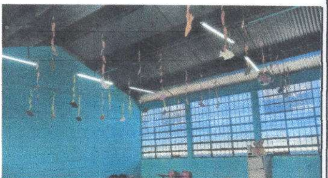
Foto 4: Sustitución de ducto electrico mas accesorios
