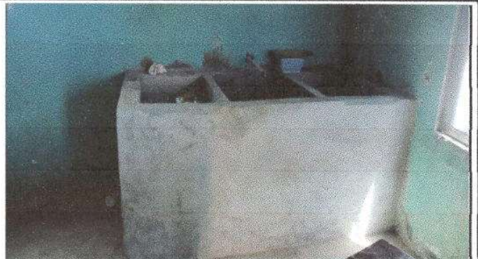
Foto 8: sustitución de pila de cemento de dos lavaderos hecha a mano
