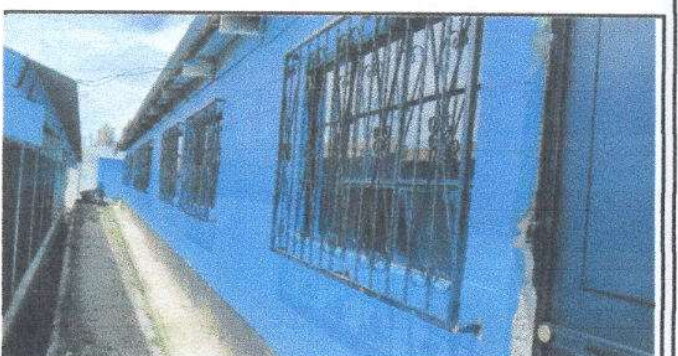
Foto 6: Fabricacion e instalacion de balcones de hierro en ventanas
