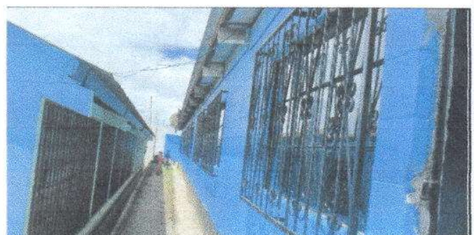
Foto 6: Fabricación e instalación de balcones de hierro en ventana
