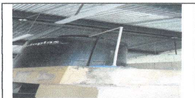
Foto 5: Sustitución de accesorios de depósito de agua
