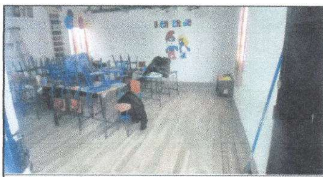
Foto 11: Aplicación de pintura color blanco en paredes internas del aula de párvulos.
