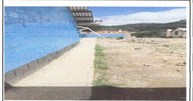
Foto 4: Sustitucion de tubería PVC línea principal de aguas negras
