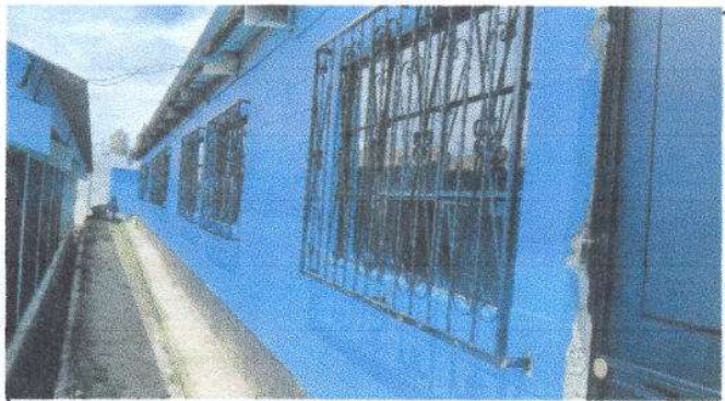
Foto 3: Sustitución de vidrios
