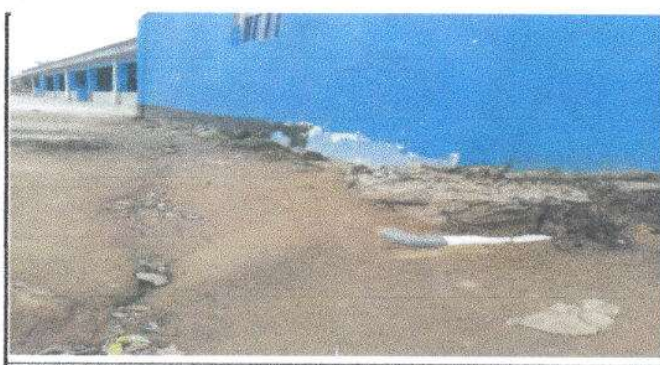
Foto 12: Introduccción de 33 metros de drenaje a fosa de baños por pila instalada.
