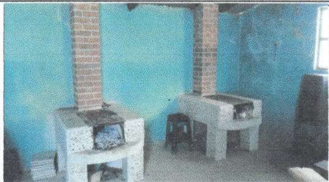
Foto 7: Sustitución de estufa rural (completa) incluye chimenea y plancha de meta
