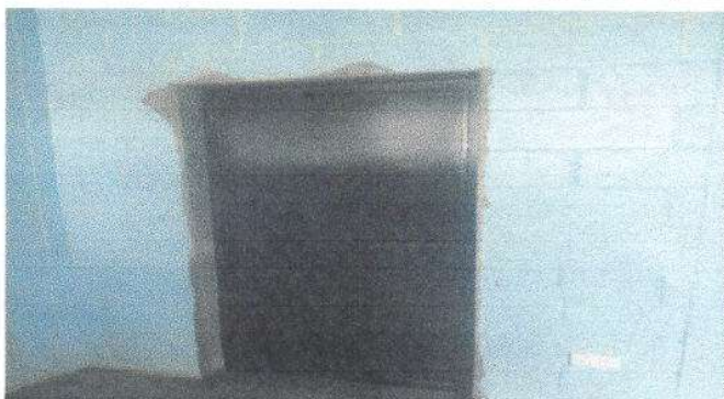
Foto 10: Apertura, fabricación e instalación de puerta
