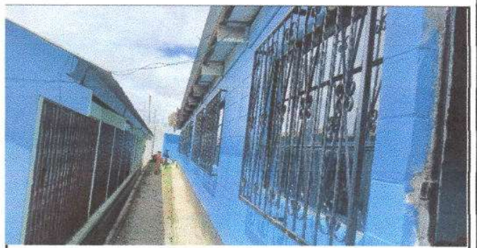
Foto 6: Fabricacion e instalacion de balcones de hierro en ventana
