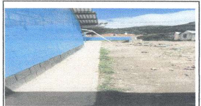
Foto 4: Sustitución de tubería PVC línea principal de aguas negras
