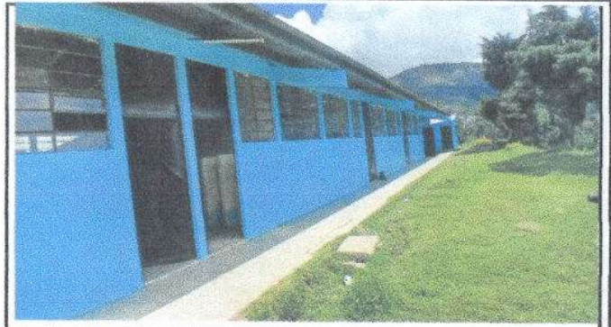
Foto 2: Mantenimiento a estructura de puertas de metal (lijado, cambio de tubo, cepillado, sujeciones, aplicación de pintura
